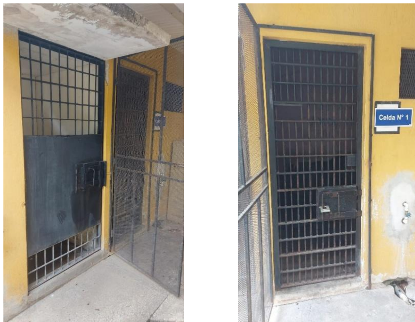
Fotos: celdas con numeración y dos puertas de seguridad.
